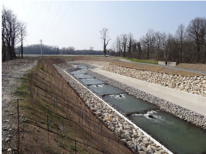
Rivière de contournement du barrage de Jons
