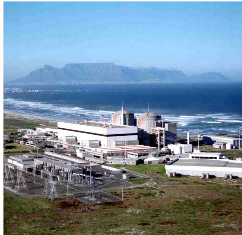
Centrale nucléaire de Koeberg (Afrique du Sud)
